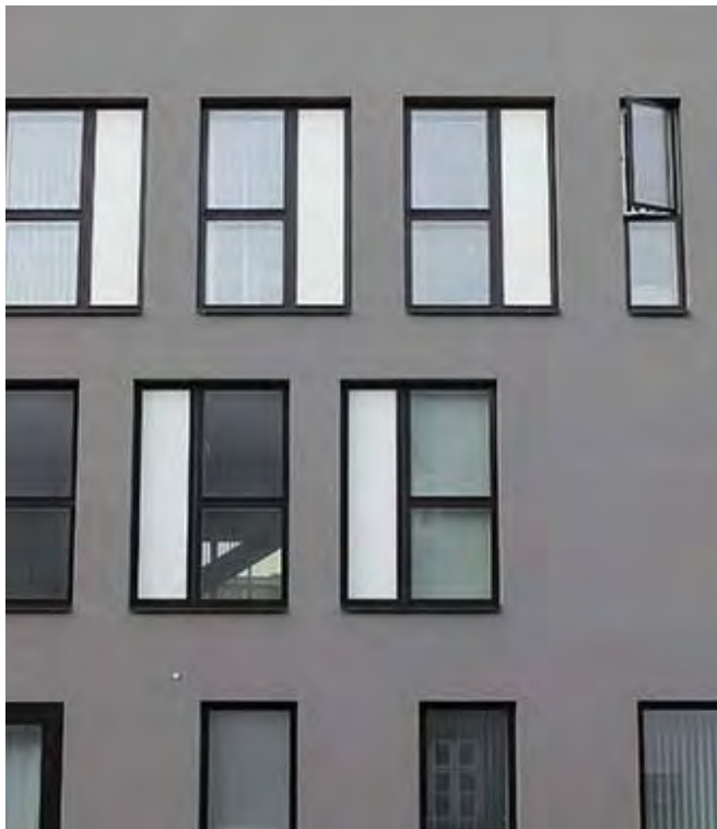
Pudset mur – primært materiale
